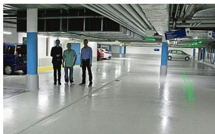
Heller und freundlicher sieht nun die sanierte Tiefgarage unter der Rathauspassage aus, im Bild (v.l.) mit Stadtbaumeister Justus Klement, Ordnungsamtsleiter Peter Holzmann und Stefan Hermann von der Atrium-Hausverwaltung. FOTO: WOS
